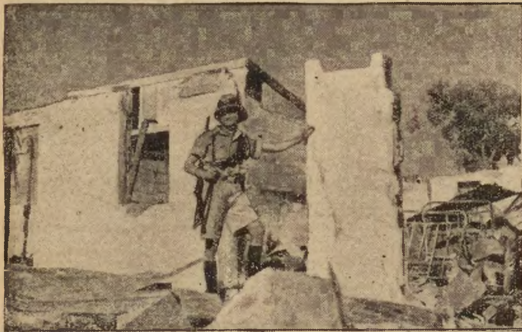
W Jaffie w czasie rozruchów arabskich liczne domy zostały zupełnie zniszczone.
