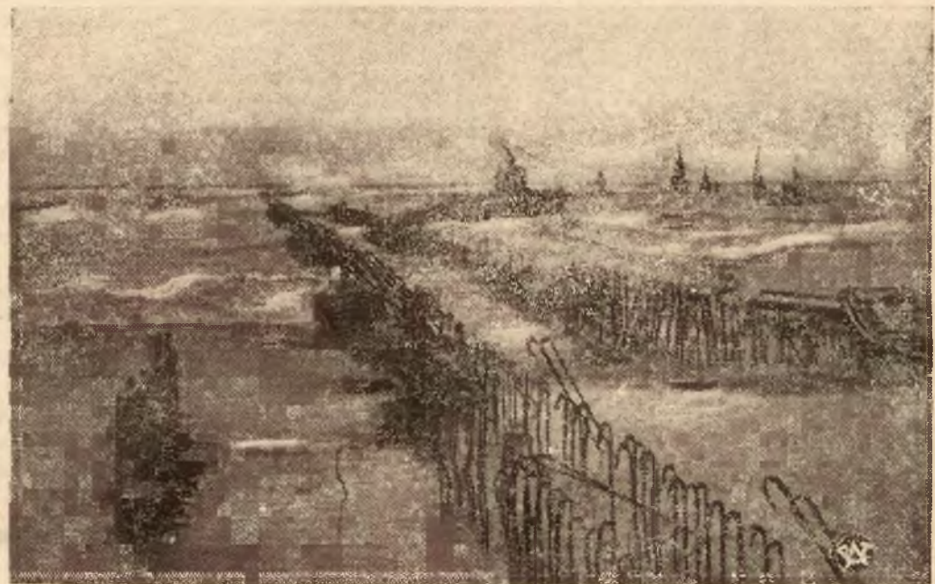
Nieustanna walka z morzem. Prace nad umocnieniem wybrzeża, a jednocześnie nad przystosowaniem tego skrawka morza do naszych potrzeb gospodarczych trwają bezustannie. Ostatnie burze jesienne poczyniły znaczne szkody przy budowie portu w Wielkiej Wsi. Zdjęcie przedstawia nowowybudowany port w Wielkiej Wsi w czasie huraganowej burzy. Woda zalała całkowicie molo i urządzenia techniczne, zatapiając kafary motorowe.
