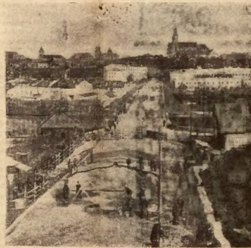
Szlak Marszałka Piłsudskiego. Widok ogólny miasta i mostu na Niemnie, na szlaku Marszałka Piłsudskiego (Warszawa—Wilno). Zdjęcie przedstawia moment układania pierwszego, dwustu-metrowego odcinka gładkiej nawierzchni na szlaku Marszałka.
