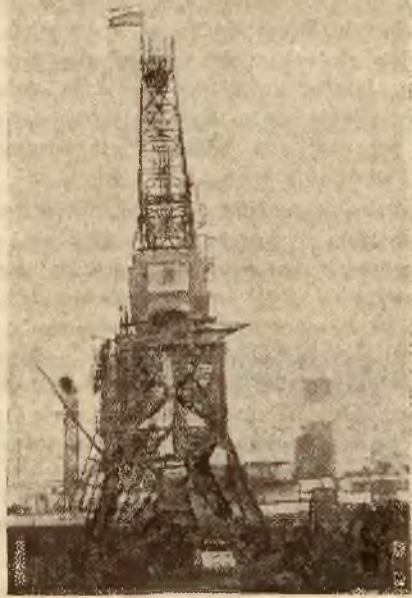
Stale rozrastający się port gdyński otrzymał ostatnio nowy najzupełniej nowoczesny urządzenie dźwig o nośności 7 ton, przy szybkości załadunku 140 ton na godz. Dźwig, którego fotografję reprodukuje, został zbudowany przez firmę „Progres”.
