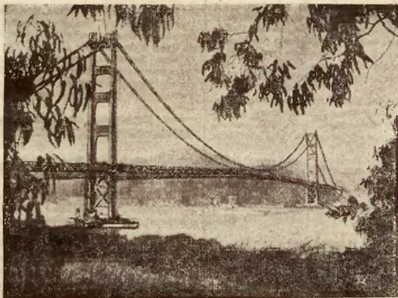
Most Złotej Bramy pod San Francisco.
