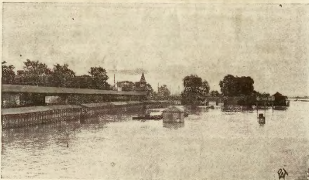
Widok na plażę kolo mostu Poniatowskiego, zatopione aż do poziomu kabin
