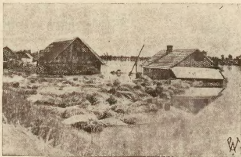
Zalane chaty, zniszczone zbiory.
