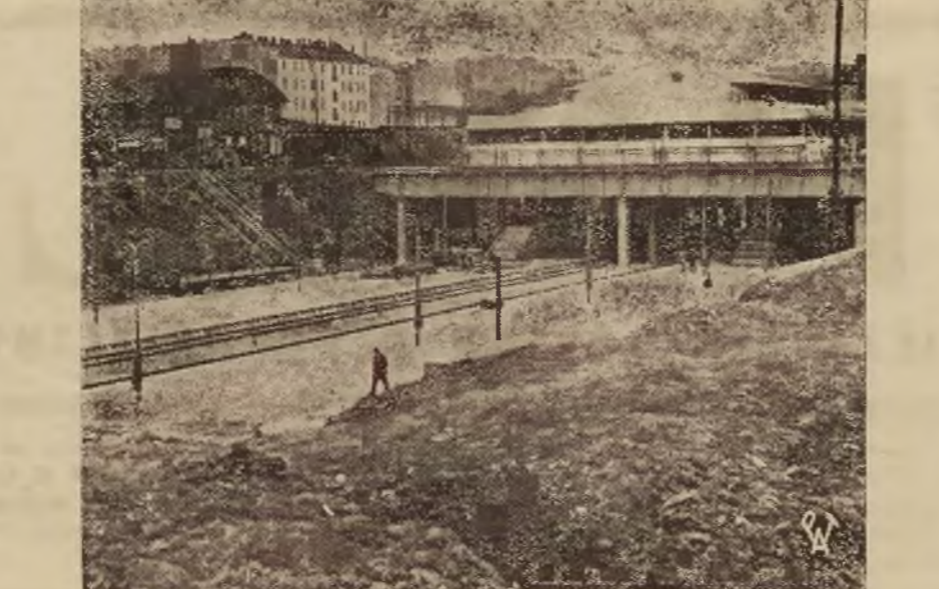
Widok na nowy tymczasowy dworzec średnicowy w Warszawie...
