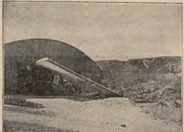
Hangar na szybowisku L.O.P.P. w Bodzowie.
