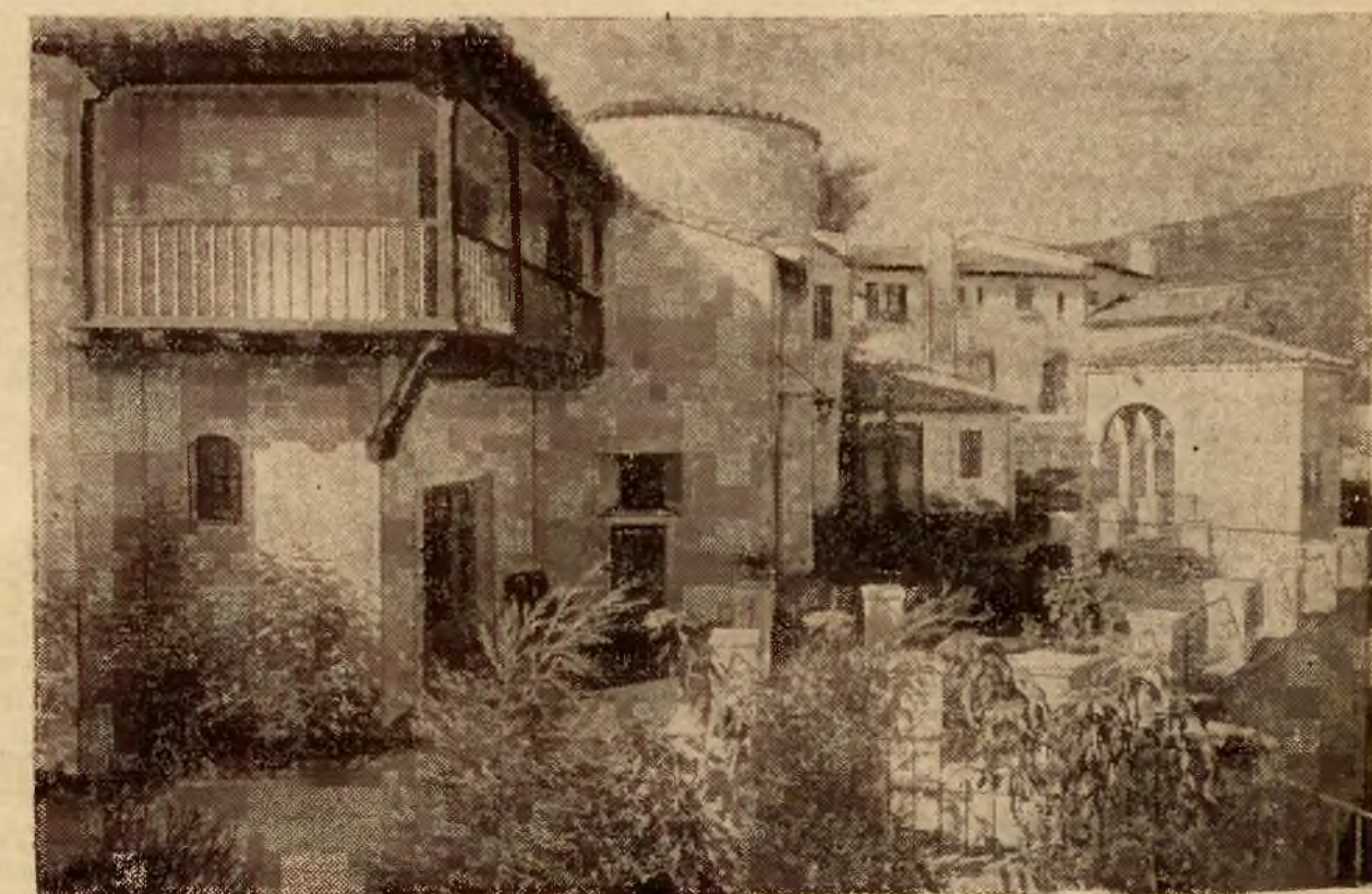
Nowy styl architektoniczny w Hollywood. Zdale od głównych arterii metropolii filmowej, powstają liczne sliczne wille w stylu hiszpańskim. Tonące w ogrodach, ze swymi balkonami, krążankami, rosną w coraz większej ilości, gdyż gwiazdy filmowe specjalnie sobie upodobały ten rodzaj wili.
