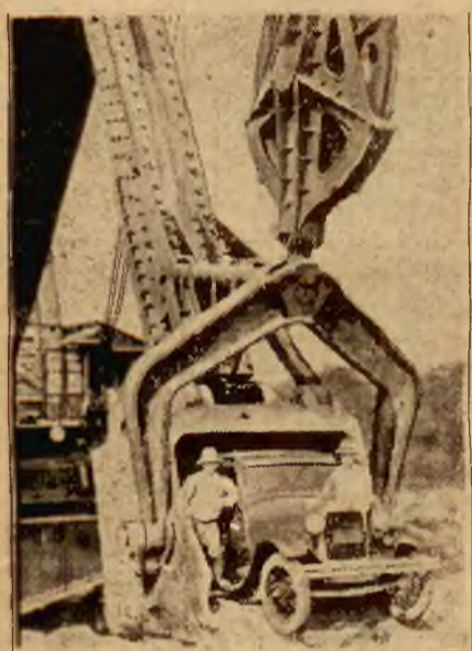
Dzwig-olbrzym. W Du Quinion-Grube w stanie Illinois zainstalowano olbrzymią elektryczną szufelę dźwigową, która ma być największą na świecie. Szufła zabiera jednorazowo 22 mtr. sześć. kapusty, którą w przeciągu pół minuty podnosi na wysokość 16 mtr. W szufli może zmieścić się i auto, jak pokazuje ilustracja.
