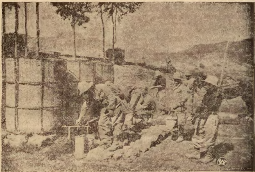
Stacja wodna w Lalaga Harmsu pod Makalle.
