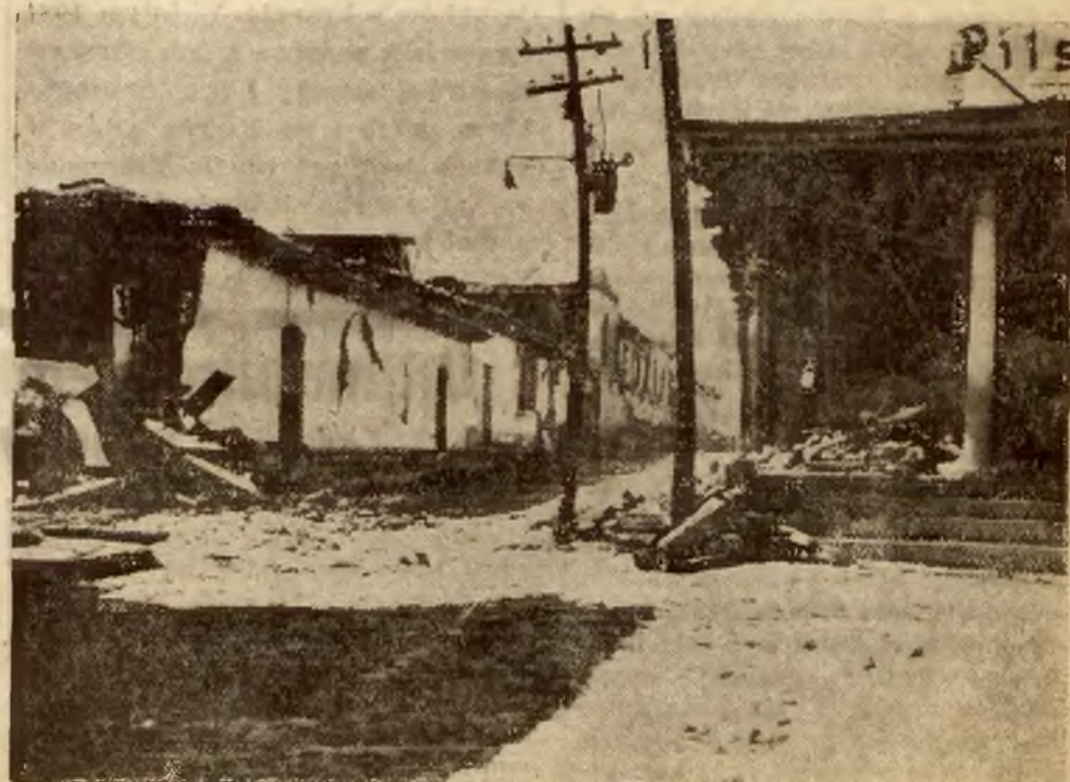
Zdjęcie przedstawia zniszczoną ulicę w miejscowości San Vicente.
