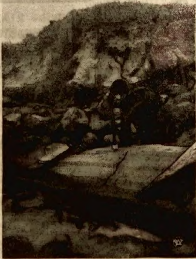
Reprodukcję olbrzymią wyrwę utworzoną przez burzę na morzu polskim w tamte holenderskiej pod Karwią. Osłona betonowa została rozbita przez szalejące żywioły.
