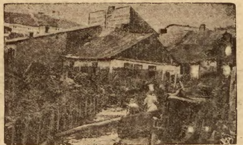
Zdjęcie wykonane na terenach nawiedzonych katastrofalną powodzią na obszarze woj. kieleckiego i krakowskiego. Powódź ta, która nadeszła nieoczekiwanie, wskutek oberwania się chmur, pociągnęła kilkadziesiąt ofiar w ludziach i zniszczyła dobytek mieszkańców na sumę wielu milio nów złotych.
