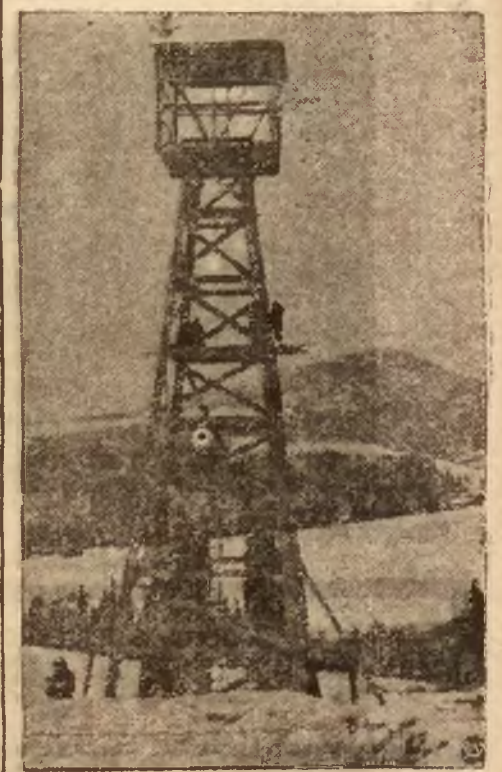
Budowa mimo zimna i śniegu drugiego z rzędu szybu naftowego w Starej Wsi, w okolicy Gorlic.
