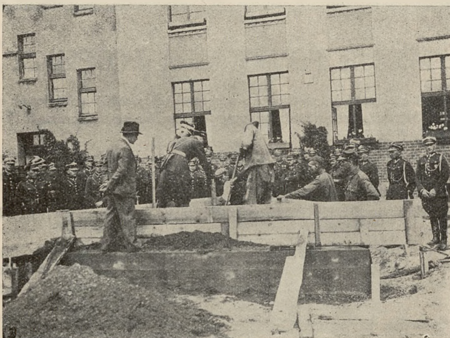
Wmurowanie aktu erekcyjnego.
