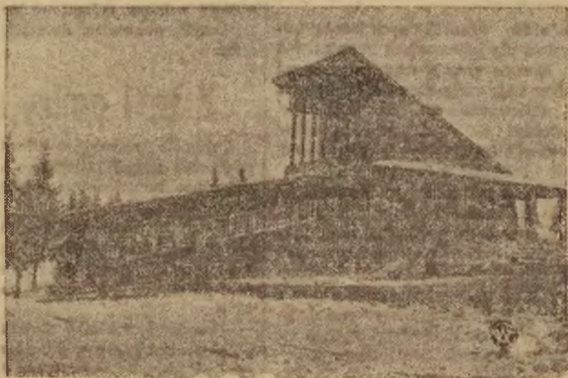
Dworzec kolejki widokowej na Gubałówce.
