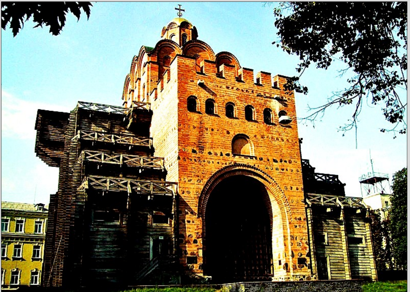
Rekonstrukcja Złotej Bramy w Kijowie
