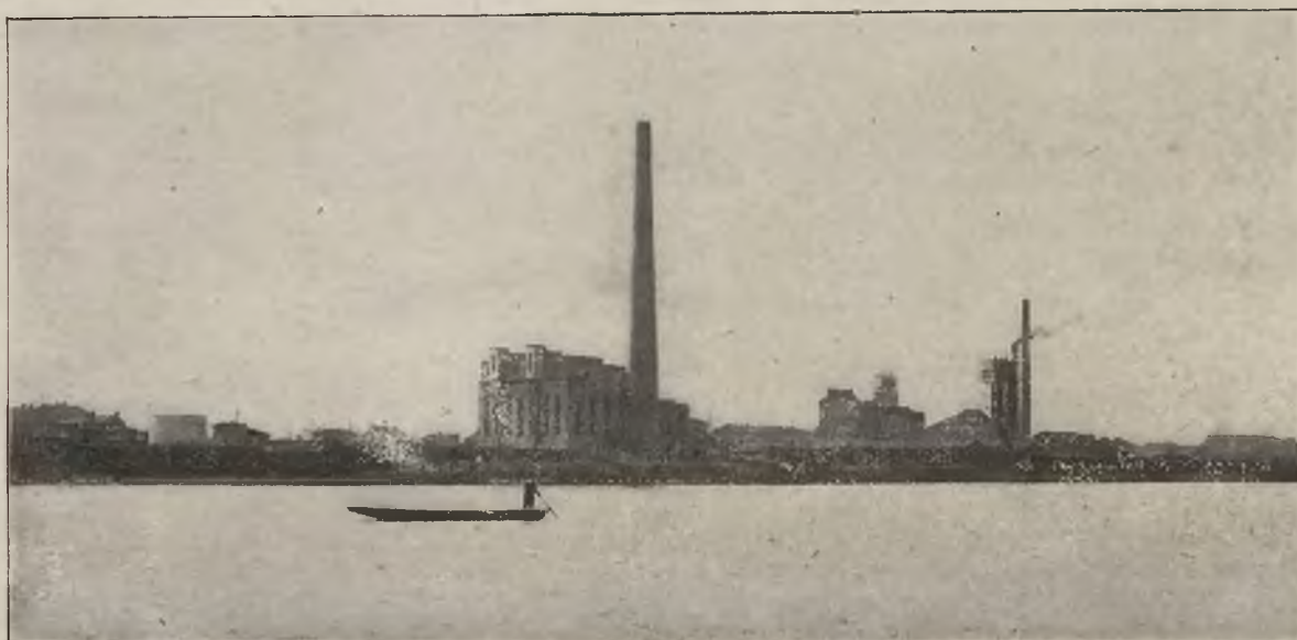
Okręgowa Kujawska Elektrownia Włocławek. Komin 65 m × 2,25 m ⊕.
