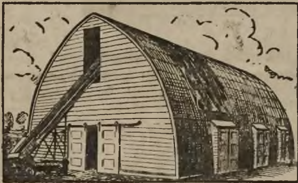
Ganzstahlscheune in Rautenneßkonstruktion.
