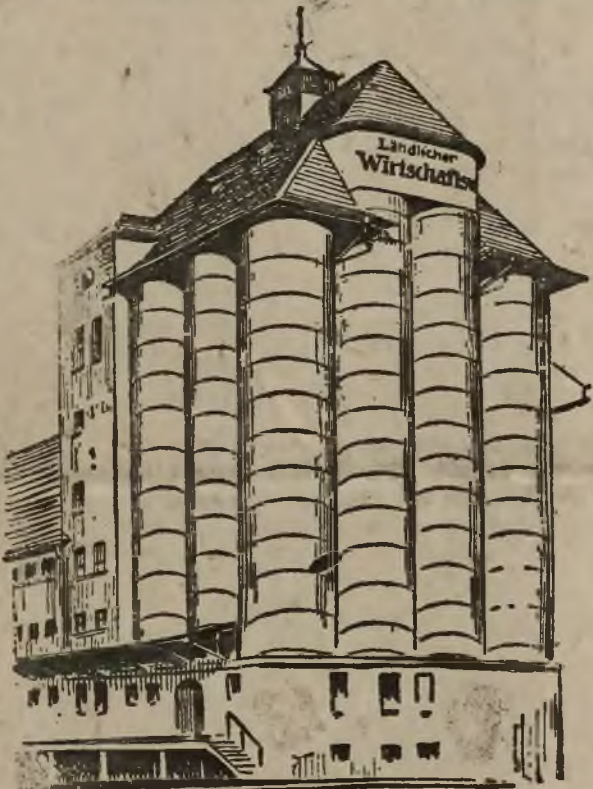
Großraum-Getreidesilo aus Stahl.
