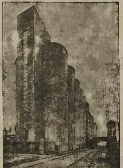
Neuer Riesen-Silo in Düsseldorf
