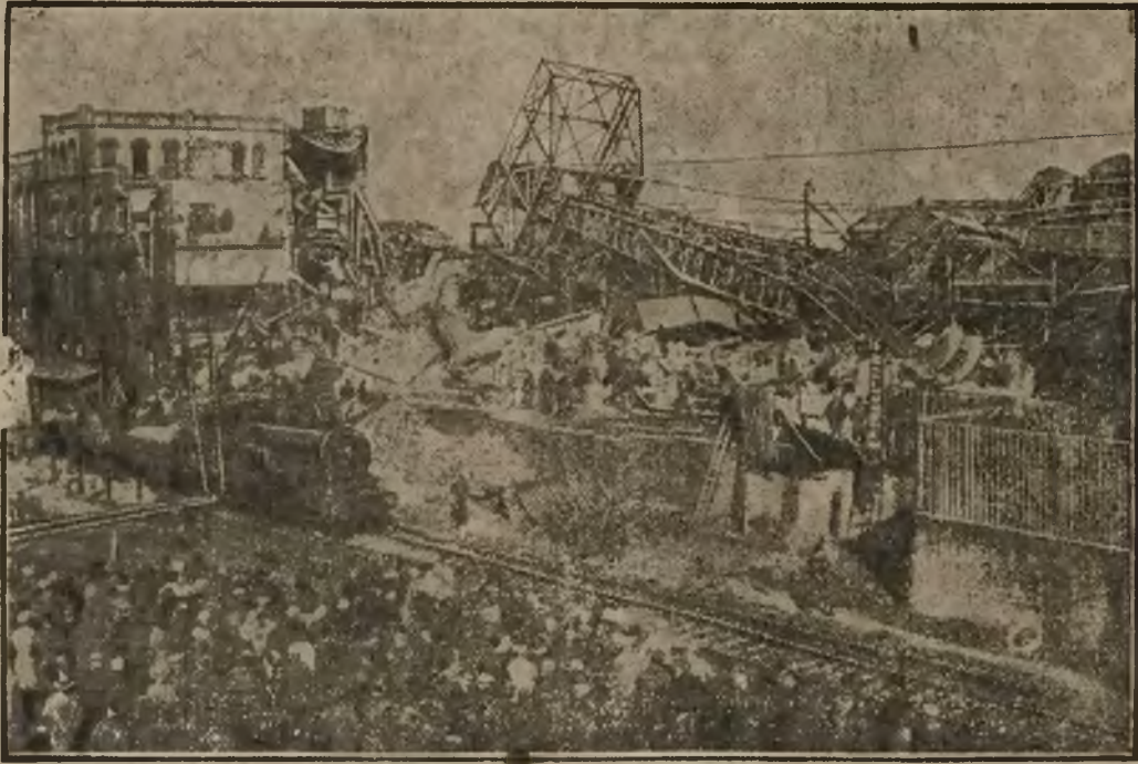
Das Trümmerfeld mit dem umgelegten Fördertrnm
