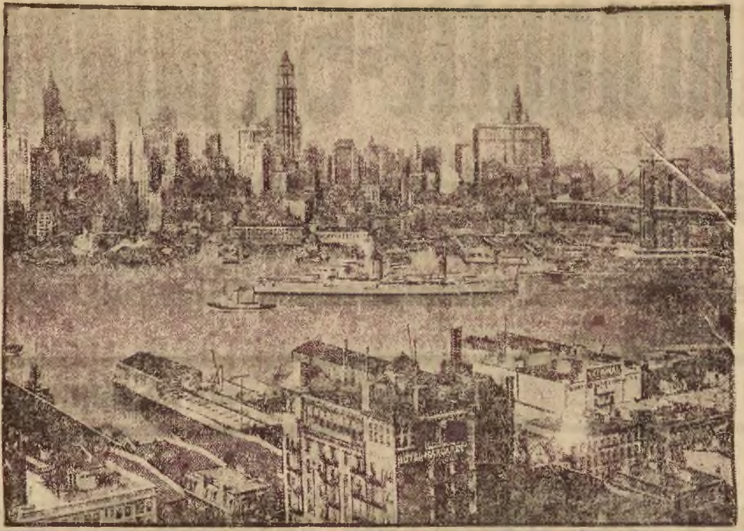
Hier ereignete sich die furchtbare New Yorker Fähr-Katastrophe Blick auf den East River in New York, auf dem ein Fährschiff durch eine Explosion völlig in Stücke gerissen wurde. Von den Passagieren wurden 49 getötet und alle übrigen, etwa 100, mehr oder minder schwer verletzt.
