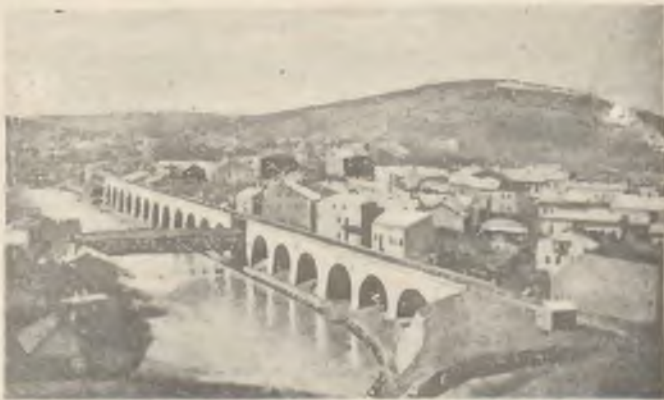
Turka n-S. Widok ogólny i wiadukt kolejowy.
