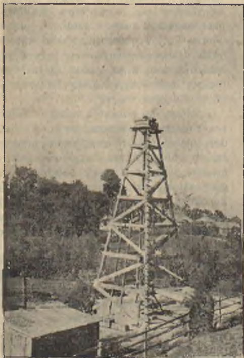
Widok na wieżę nad wierconą studnią głębinową w Krzemieńcu
