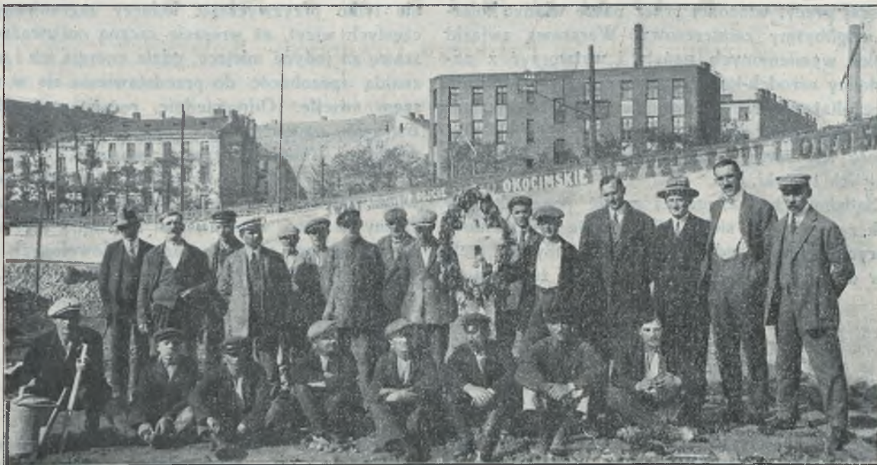
GRUPA PRACOWNIKÓW, ZAJĘTYCH PRZY PRZEBUDOWIE TORU NA DYNASACH
