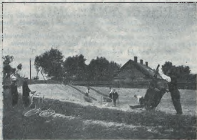
BUDOWA TORU K. S. „MAZOVIA“ W MIŃSKU MAZ.
