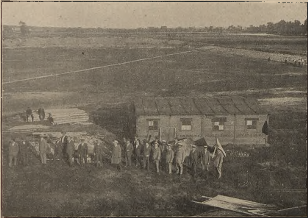
Grupa inicjatorów i wykonawców na tle rozpoczętych prac przy budowie, ukończonego już, toru w Kaliszu
