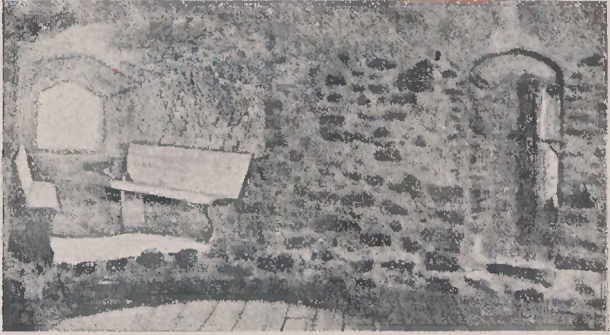
F. 6. Zamek w Olofsborg Finlandia. Izba w okrągłej wieży z 1477. Por. wątek f. 9, 10.
