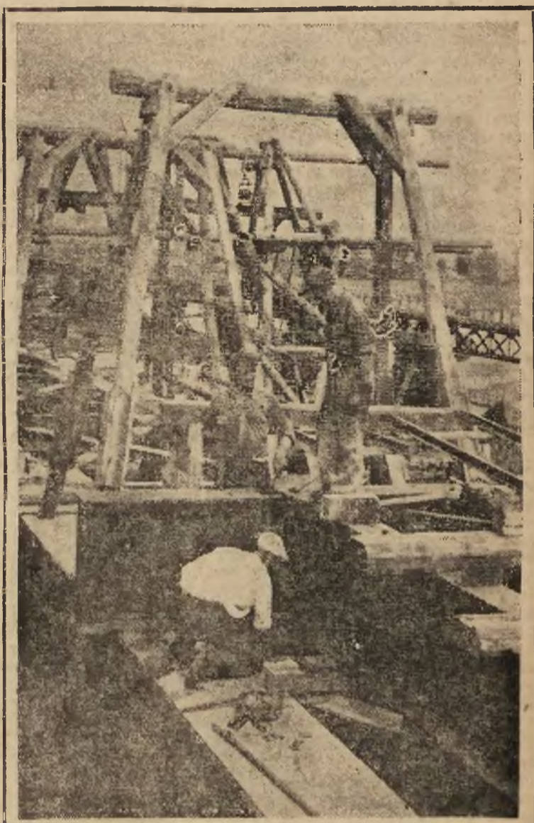
Montowanie przesła na moście kolejowym w Warszawie
