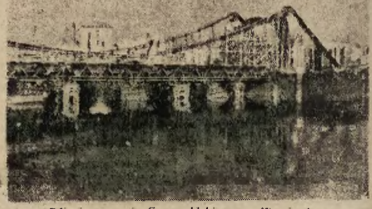
Odbudowa mostu Grunwaldzkiego we Wrocławiu
