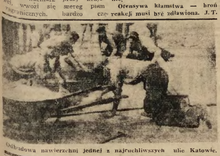
Odbudowa nawierzchni jednej z najruchliwszych ulic Katowic.
