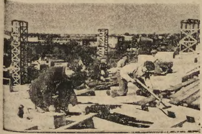
Wre gorączkowa praca nad odbudową...
