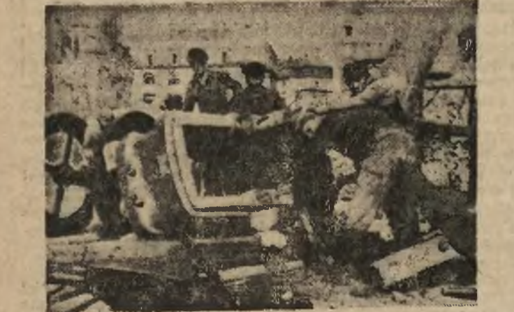
Montowanie maszyny do mielenia gruzów
