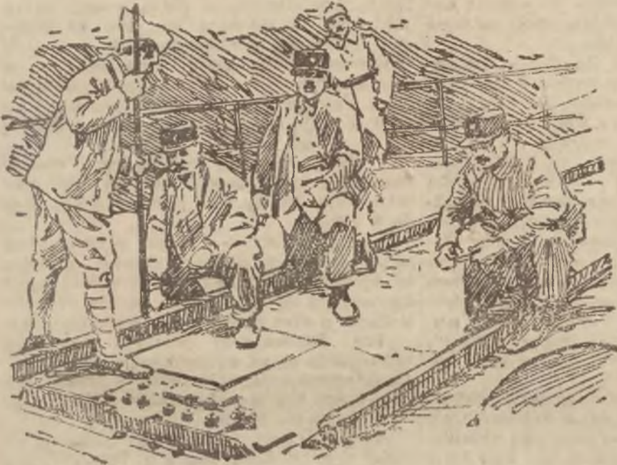
Naprawa wyrwanych przez Niemców szyn kolejowych.
