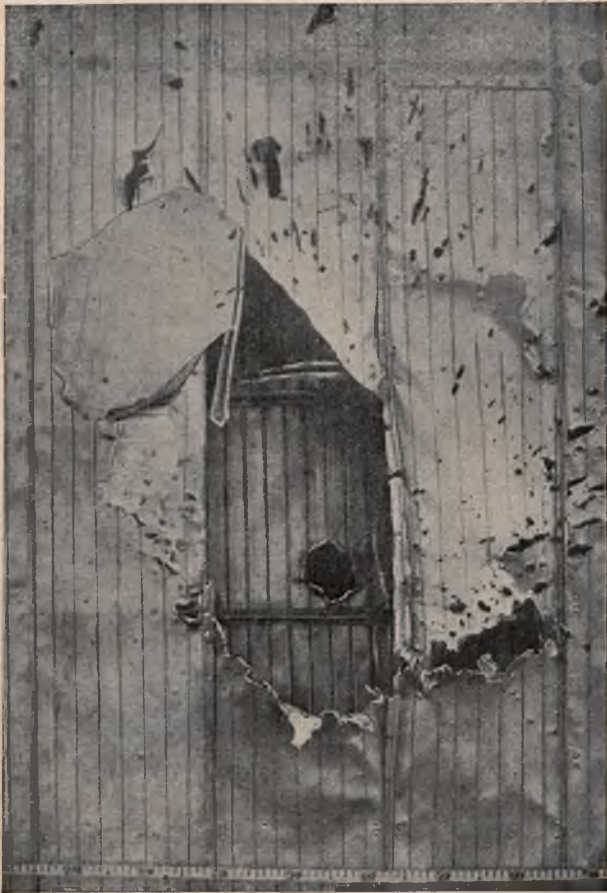
Efekt pocisku kruszącego przy trafieniu w skrzydło całkowicie metalowe.
