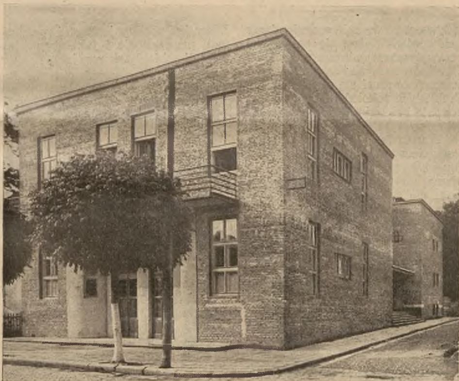
Prawe skrzydło domu Legionowo-Strzeleckiego, im. TADEUSZA HOŁÓWKI w Drohobyczu. — Na lewo (widoczna część parkaniku i dachu) nierozebrana jeszcze połowa starego budynku w miejscu, gdzie stanąć ma druga część domu. ~ (Opis powstania domu umieszczony został na str. 12 n-ru w Kronice Legionowo-Peowiackiej).
