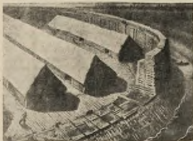
Półwysyp umocniony był drewnianym wałem obronnym, wypełnionym ubitą ziemią
