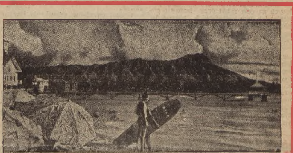
Departament wojny i obrony St. Zjedn. Półn. Am. przystąpił do fortyfikacji wysp hawajskich na Pacyfiku. Po ukończeniu gigantycznych robót fortyfikacyjnych: — betonowych schronów, podziemnych składów amunicyjnych, założenia dokoła wysp kilkakrotnego pierścienia min wybuchowych — staną się wyspy hawajskie najsilniejszą fortecą świata i główną bazą operacyjną amerykańskiej floty wojennej.
