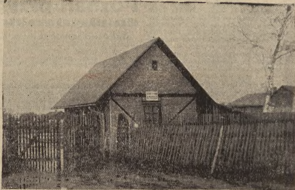
Budynek Urzędu Gminnego w Dąbrowie.
