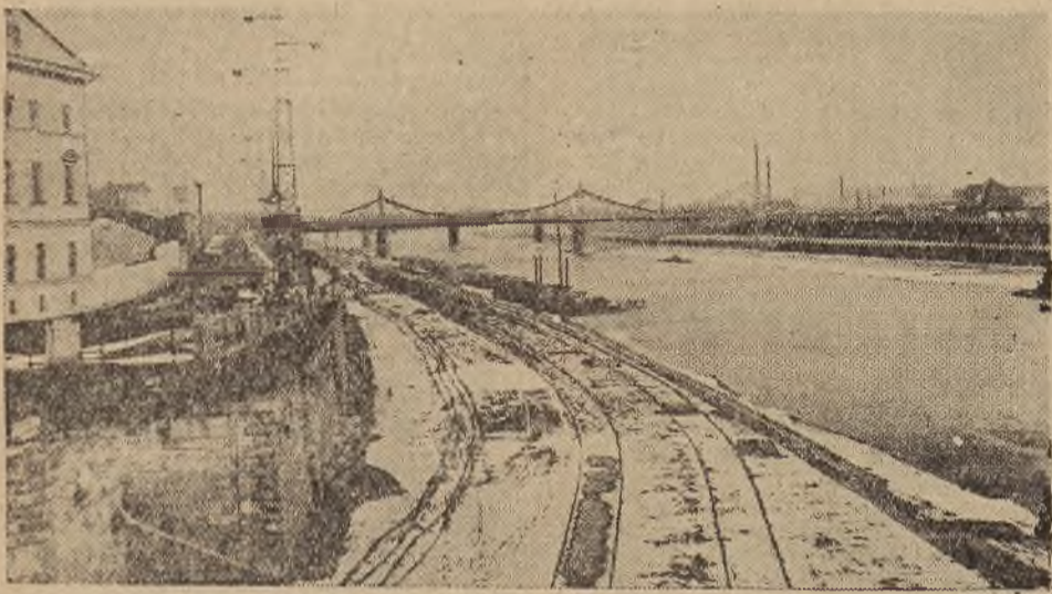
Widok na III most na Wiśle, t. zw. „most bezrobotnych”.
