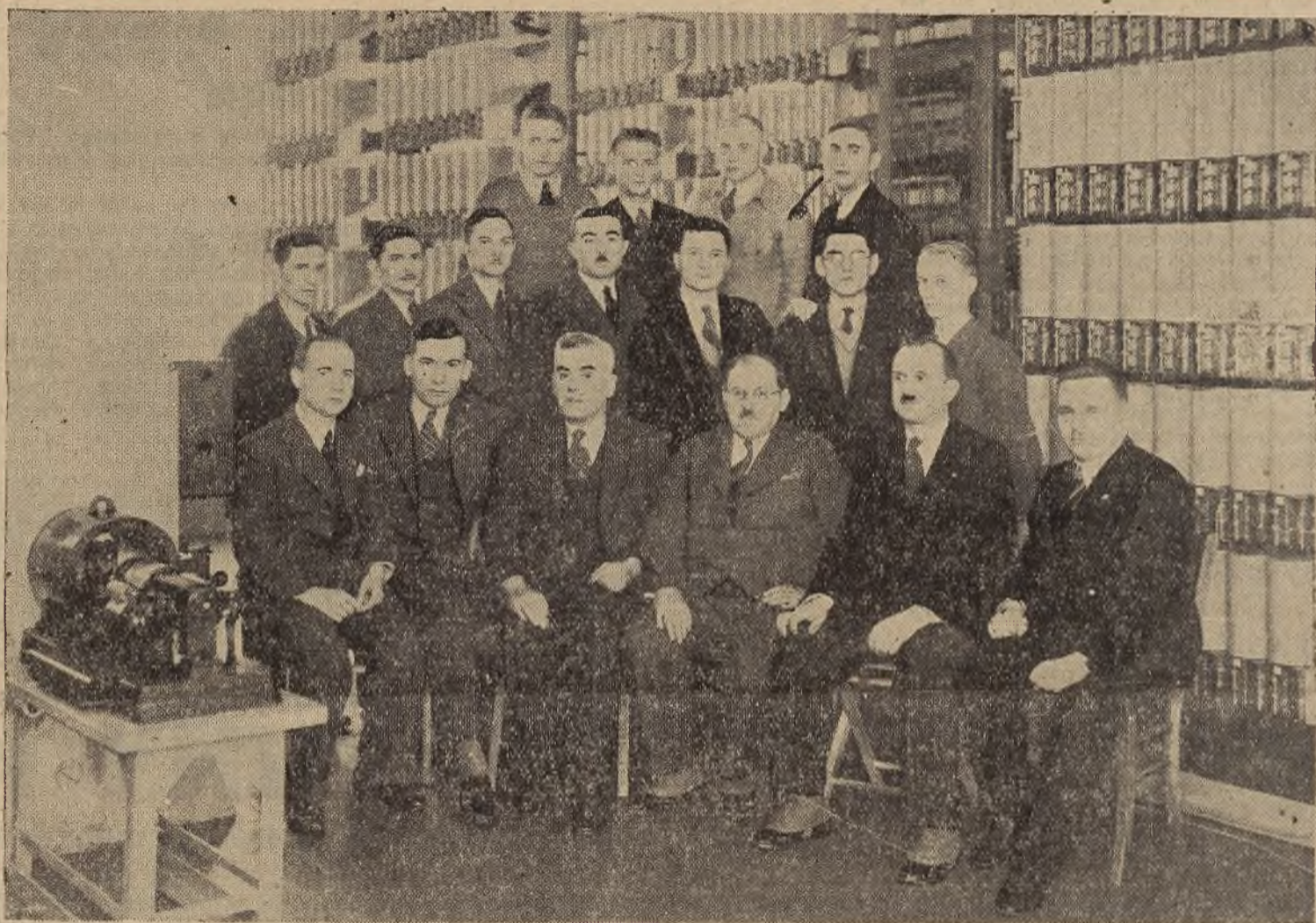
W ub. środę przedstawiciele Śląskiej prasy na zaproszenie dyrektora Poczty i Telegrafów w Katowicach, p. Kozubka, zwiedzali nowe urządzenie automatycznej centrali telefonicznej. W otoczeniu personelu technicznego w pierwszym rzędzie siedzi (czwarty od lewej strony) p. Kozubek, dyr. Poczty i Telegrafów w Katowicach.
