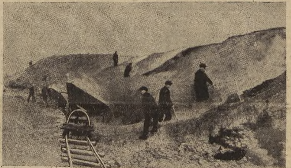
Roboty przy usuwaniu hałd obok kopalni „Flora“ pod Dąbrową Górniczą.
