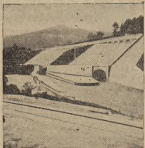
Wyloty tuneli, odprowadzających nadmiar wody.
