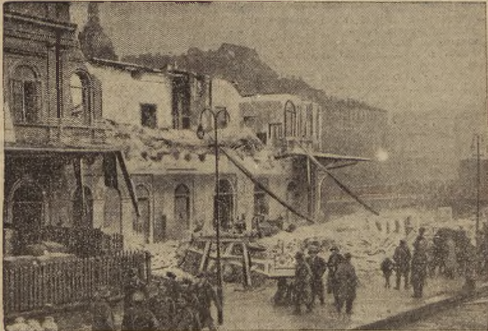
W Warszawie podczas przebudowy głównego dworca zapadła się przy rozbiorze jedna ze ścian, przyczem 2 robotników poniosło śmierć, a 5 zostało ciężko rannych.
