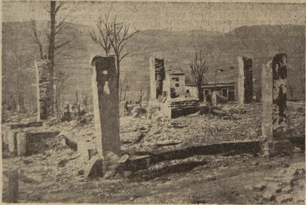
Zgliszcza domu Wojciecha Rusa, gdzie powstał pożar.
