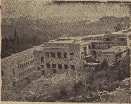
Budowa sanatorium dla dzieci śląskich na południowym stoku Kubalonki.
