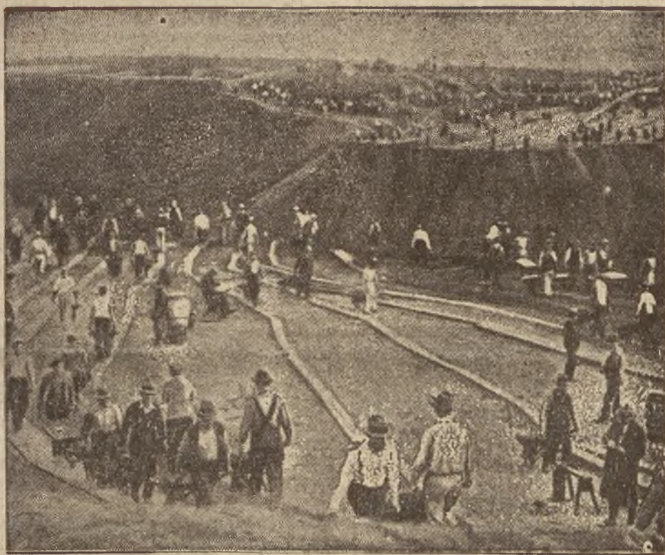
Tak Ameryka walczy z bezrobociem: 3.500 bezrobotnych pracuje nad budową szosy, okalającej jezioro „Merced” pod San Francisco — jak to niniejsza rycina przedstawia. Takich i tem podobnych robót użyteczności publicznej podjęto wiele w Stan. Zjedn. i na dużą skalę.
