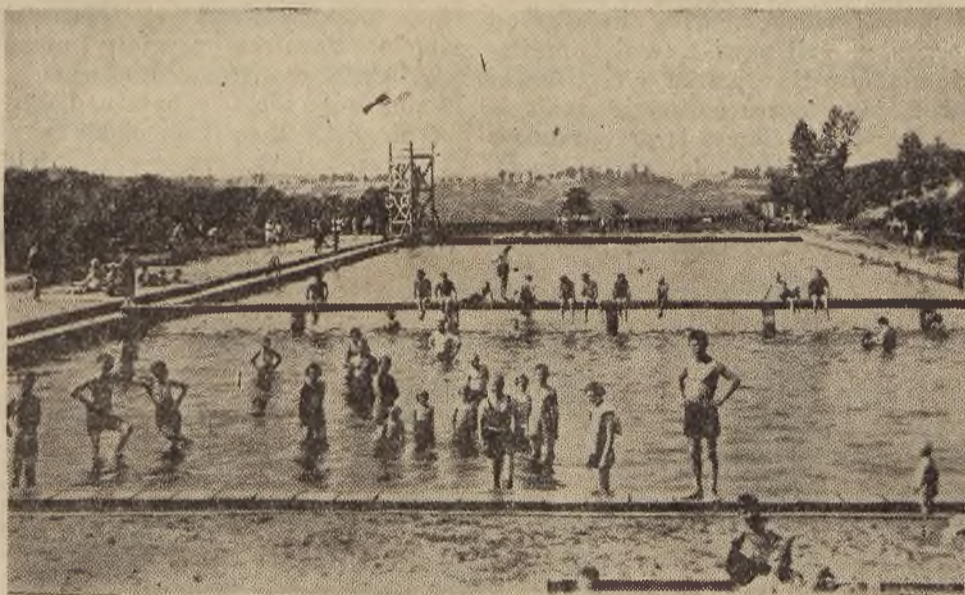
W dniu 24 czerwca br. została otwarta i oddana do użytku publicznego pływalnia na boisku sportowym K. S. Slavji w Rudzie Śl. Pływalnia, zbudowana wysiłkiem i kosztem kilku członków K. S. Slavji, posiada wszelkie nowoczesne urządzenia. Przestrzeń jej wynosi 75x25 mtr. przy głębok. od 3,50 do 0,20 mtr. W najbliższych dniach ma nastąpić poświęcenie pływalni.
