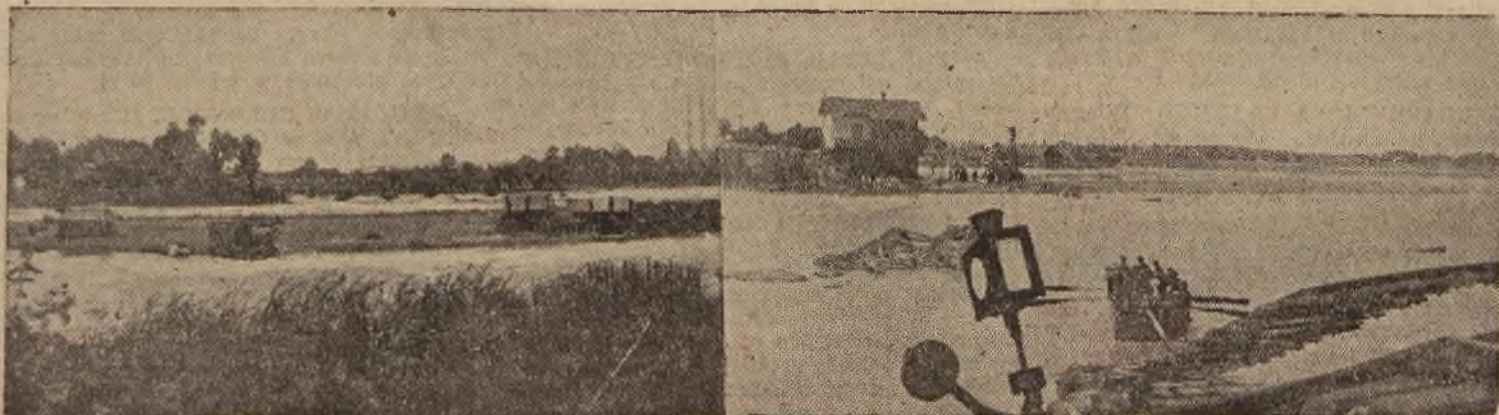
Z TERENÓW, DOTKNIĘTYCH KLĘSKĄ POWODZI.
