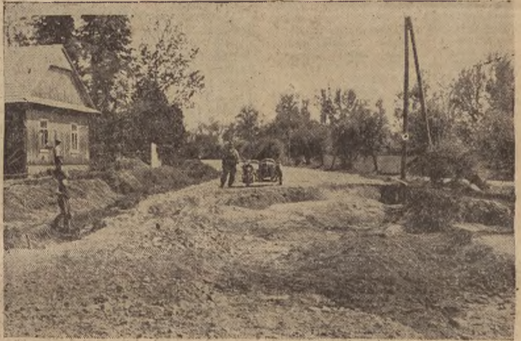
Zniszczona przez wylew Dunajca droga we wsi Wesolów, obok Zakliczyna.
