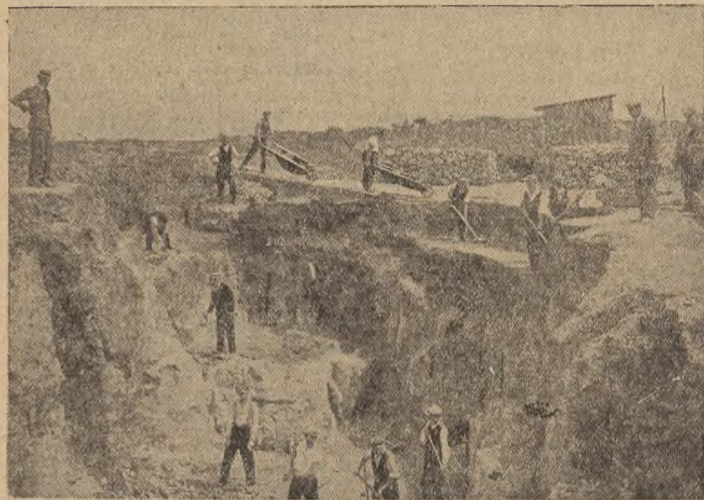
Kamieniołomy pod Zawierciem. Wydobywanie materiału na budowę dróg i ulic w Zawierciu.
